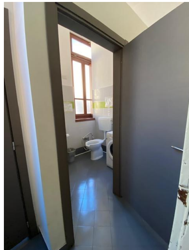
Bagno per disabili
